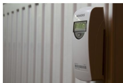
Razdjelnici topline mjere potrošnju energije radijatora. To rade tako da mjeru razliku temperature  $\Delta T$  radijatora i temperature zraka ispred radijatora (ispred razdjelnika) i vrijeme trajanja, te razlike temperature.
